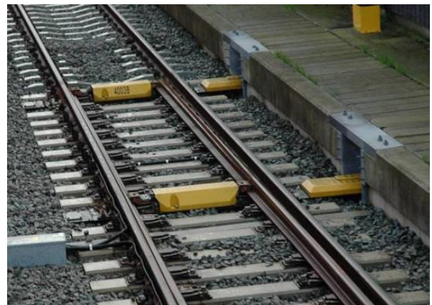
Figuur 4.11-1: Voorbeeld wisselbediening bij een wand
